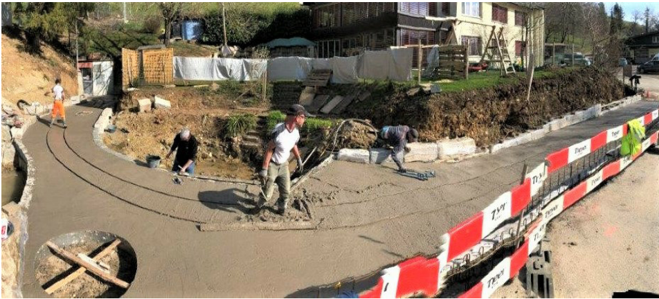
Das Gleis zum Stolleneingang wird einbetoniert.
